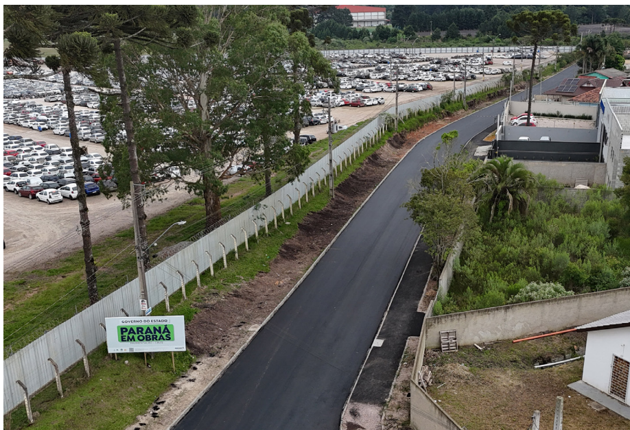
Pavimentação da Estrada da Roseira, em São José dos Pinhais, que recebe financiamento do SFM
