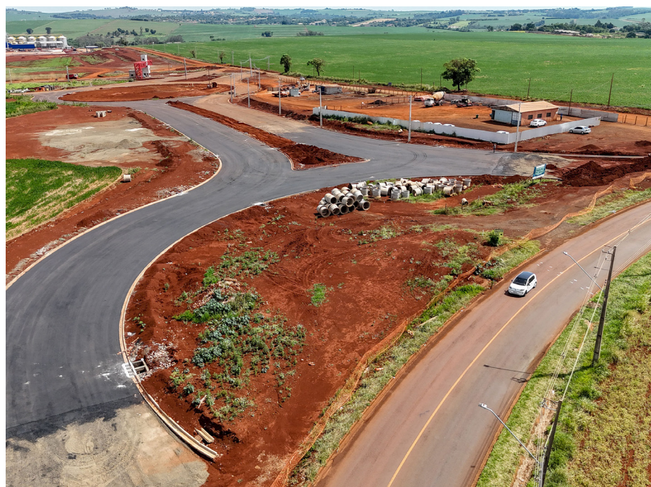
Após drenagem e terraplanagem, está sendo feita a pavimentação, infraestrutura e iluminação
